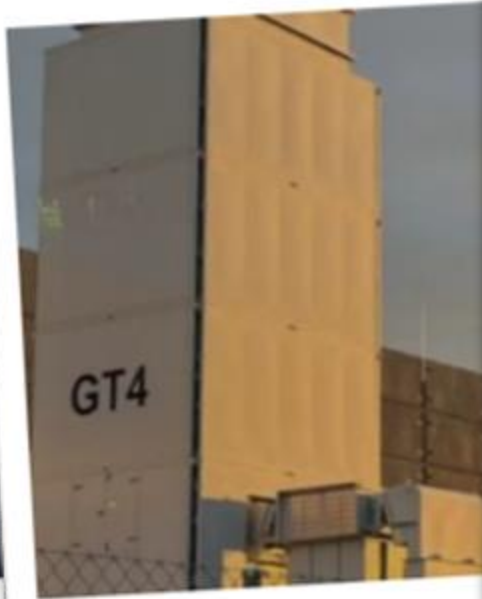
Reservekraftwerk in Birr. Foto: zVg
